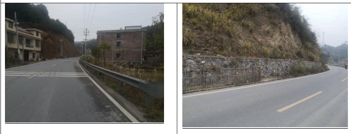
公路两侧边坡防护
