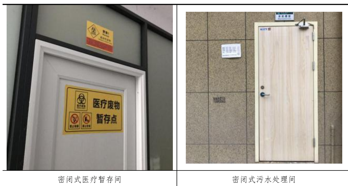
图 4-2 废气处理设施照片
