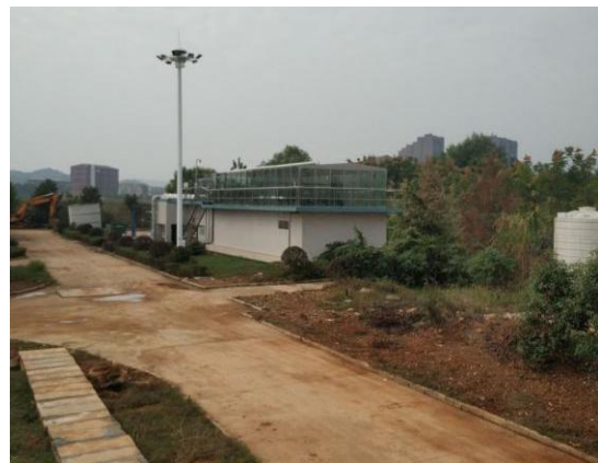
细格栅及平流曝气沉砂池
