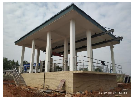
纤维转盘滤池（本期工程）
